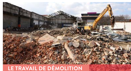
LE TRAVAIL DE DÉMOLITION
