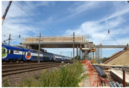
Pose du tablier du pont route des Frais Lieux en juillet 2016 ©ABommart
