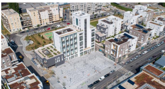
Le nouveau silo et son parvis – crédit : Clément Chauvet – juin 2019
