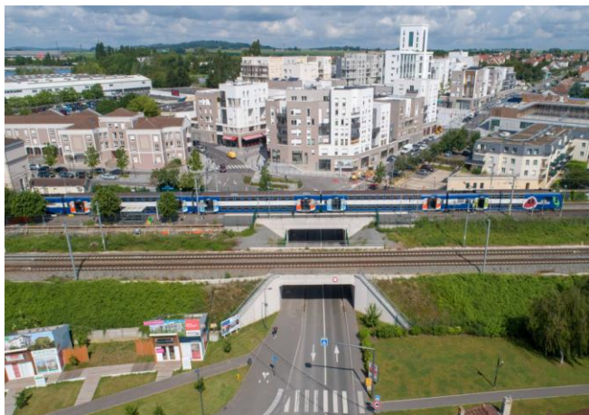
Le pont élargi et le quartier gare - crédit : Clément Chauvet – juin 2019
