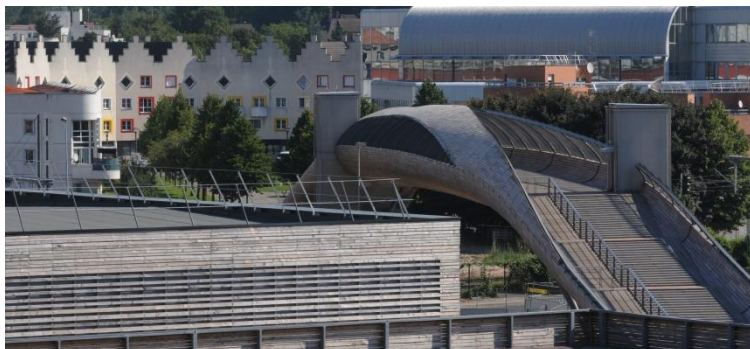
La passerelle qui relie l'université au centre-ville ©A.Bommart
